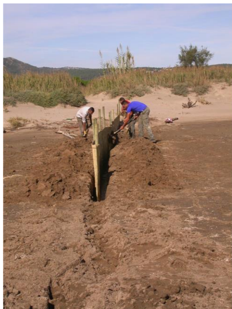
Fig. 5. Instal·lació de trampes de interferència èdica per a la regeneració dunar.
