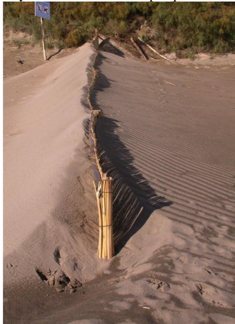
Fig. 5. Instal·lació de trampes de interferència èdica per a la regeneració dunar.
