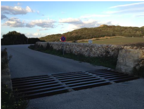
Fig. 1. Pas de bestiar 1, carretera del Cap de Cavalleria.
