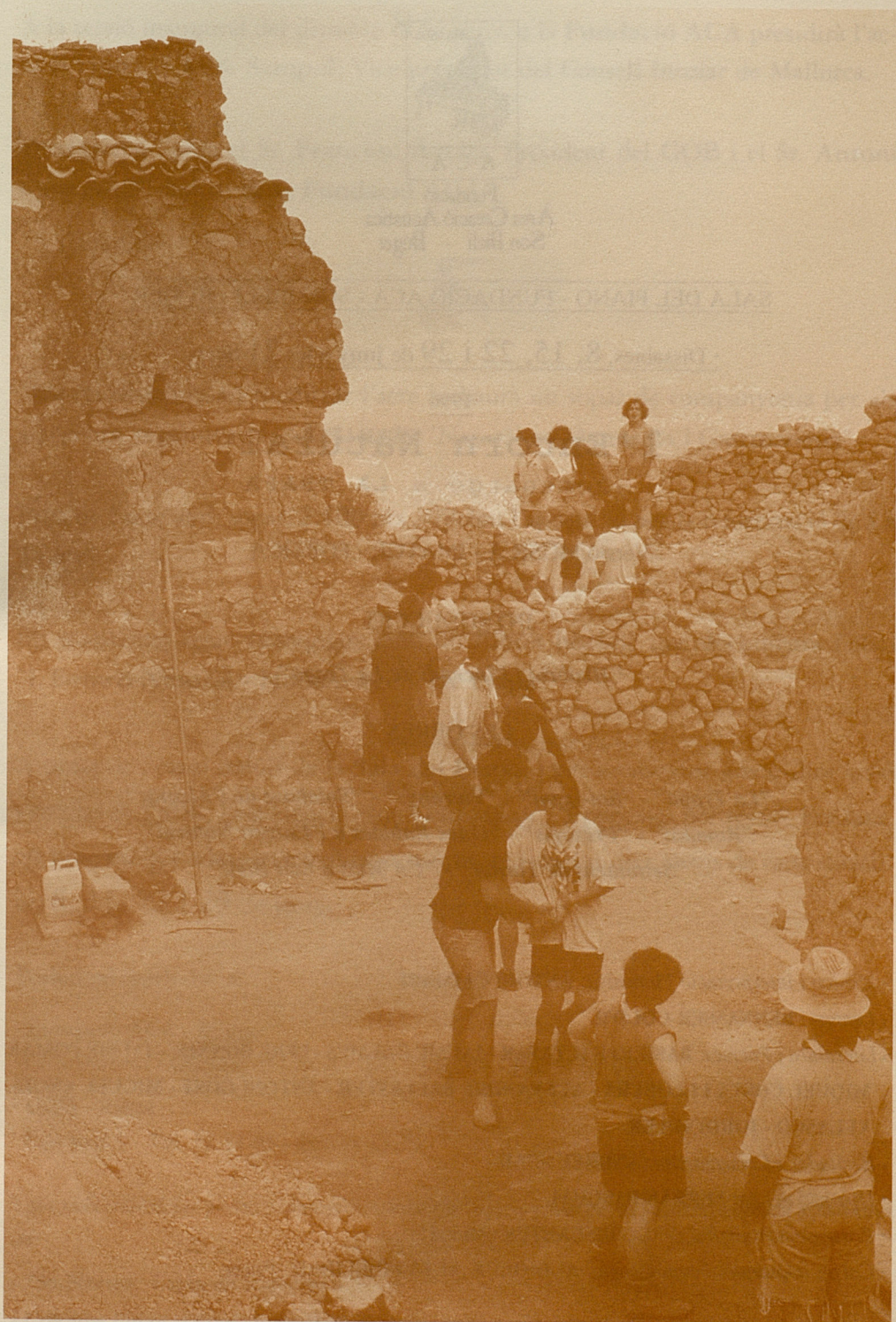
La tasca dels voluntaris constitueix una aportació important per la reconstrucció de La Trapa. Foto: Bennàsser Colom
