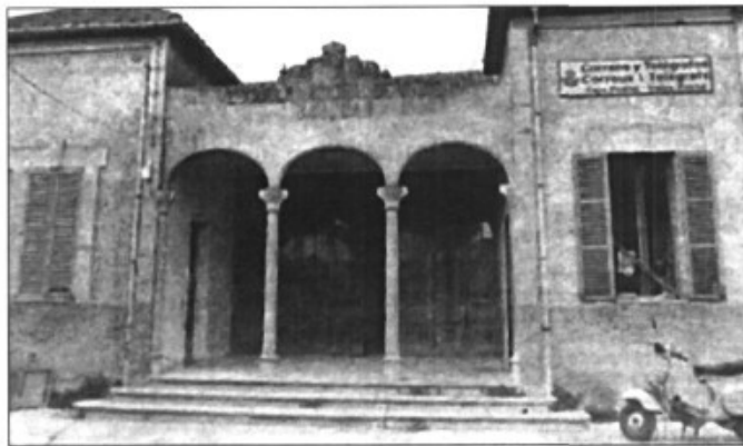
Les obres de reforma de l'Escola de les Nines i de la casa de la mestra ja han passat dues certificacions d'obra satisfactòriament.
