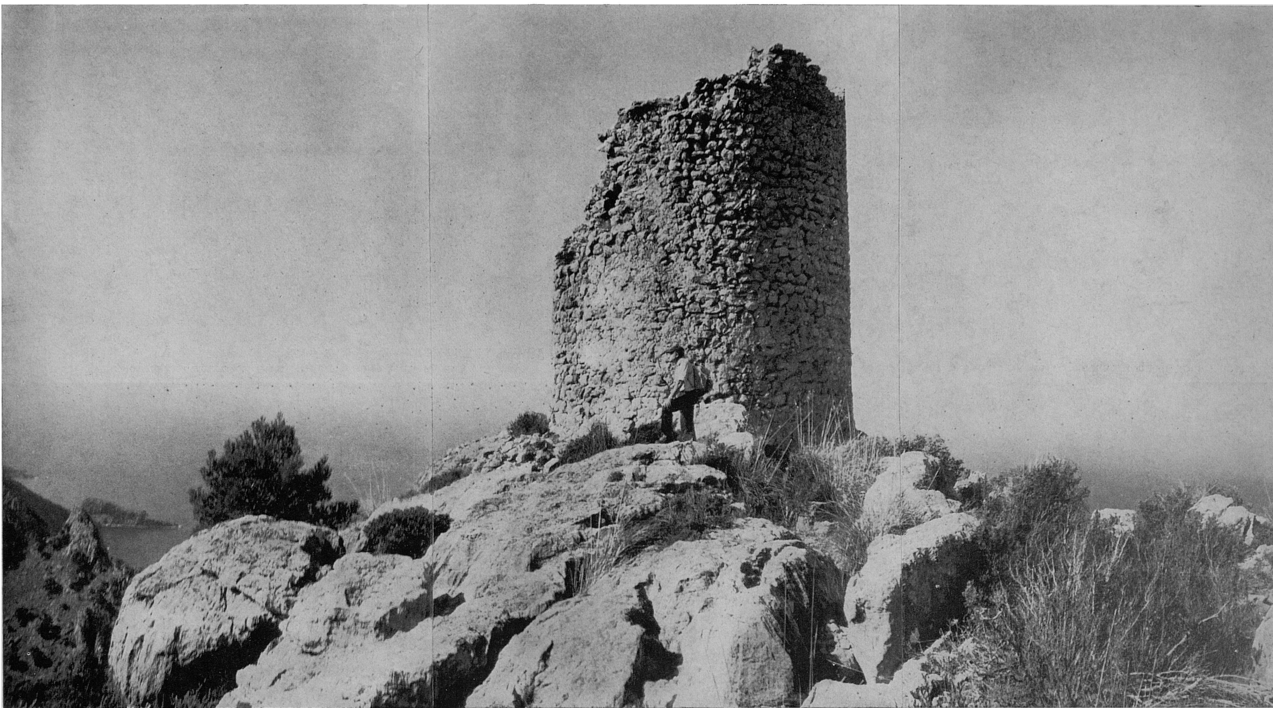
78. Assolim el cim, i, en arribar, prenim aquesta vista de la vella torre de senyals de Sa Seca pel seu costat sud-est. Allà avall, a l'esquerra, es veu a la fotografia, sortint per darrere el peu marítim del Puig de Bàlitx i el seu caient damunt la mar, l'Illeta, en primer lloc, i, més enllà, la Punta Llarga del racó marítim de Ses Camòres, apèndix septemtrional del turó promontori de la Torre Picada.
