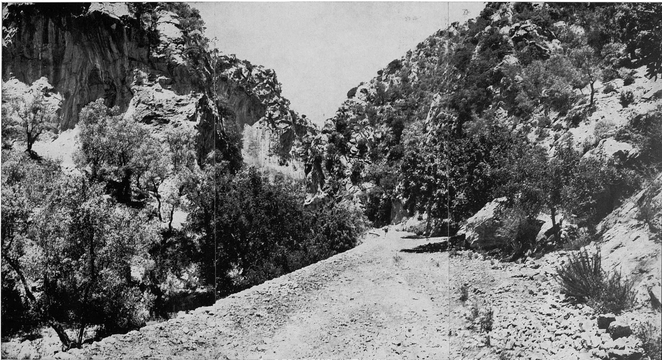
22. El camí que ens va pujant, acondicionat i artificialment elevat sobre la llera del torrent —que de natural seu ocupava tot el fons del canó— es dirigeix cap a S'Estret.
