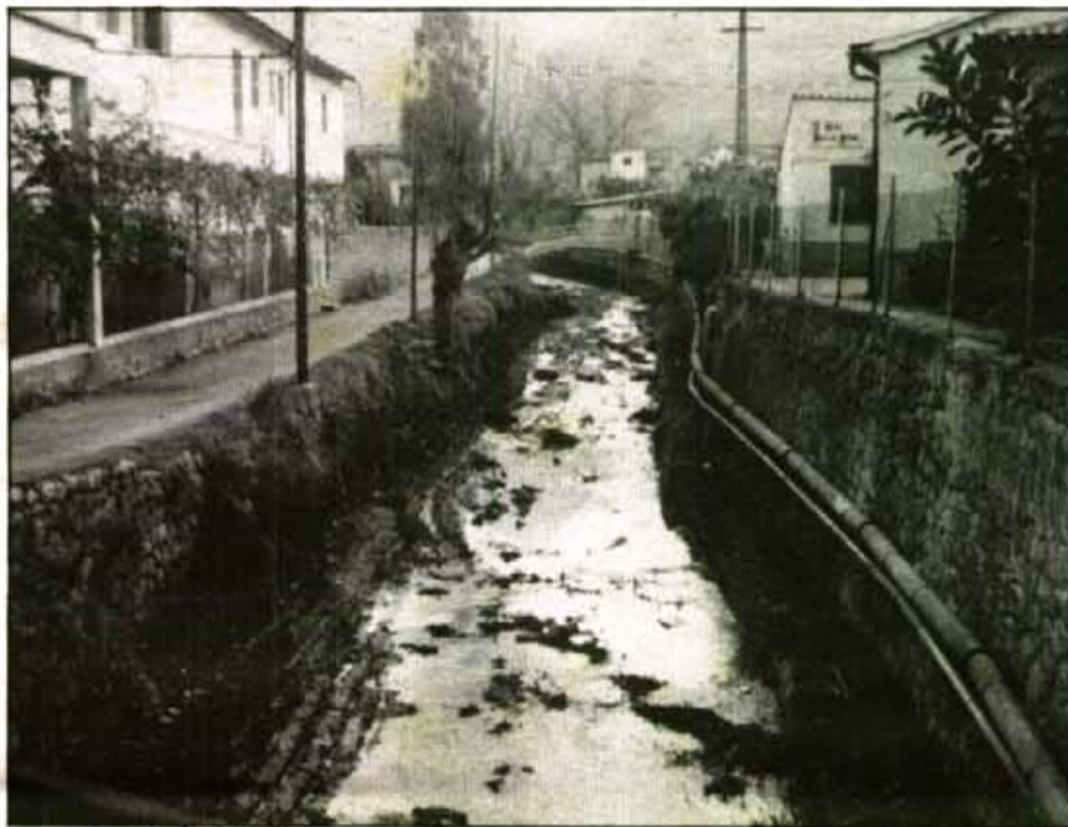
El torrent de Biniaraix, a l'altura des Pont dets ases, ja està ben net. L'empresa EMDECO, per encàrrec de la Conselleria d'Obres Públiques, en concret del Servei Hidràulic, realitza desde fa dues setmanes les obres. L'ordre és de llevar esbatzers, i arbusts de dins el torrent, i anar aplanant el llit del torrent, des del Pont on s'ajunten el torrent major i el de Biniaraix, fins a l'Alqueria del Comte.
