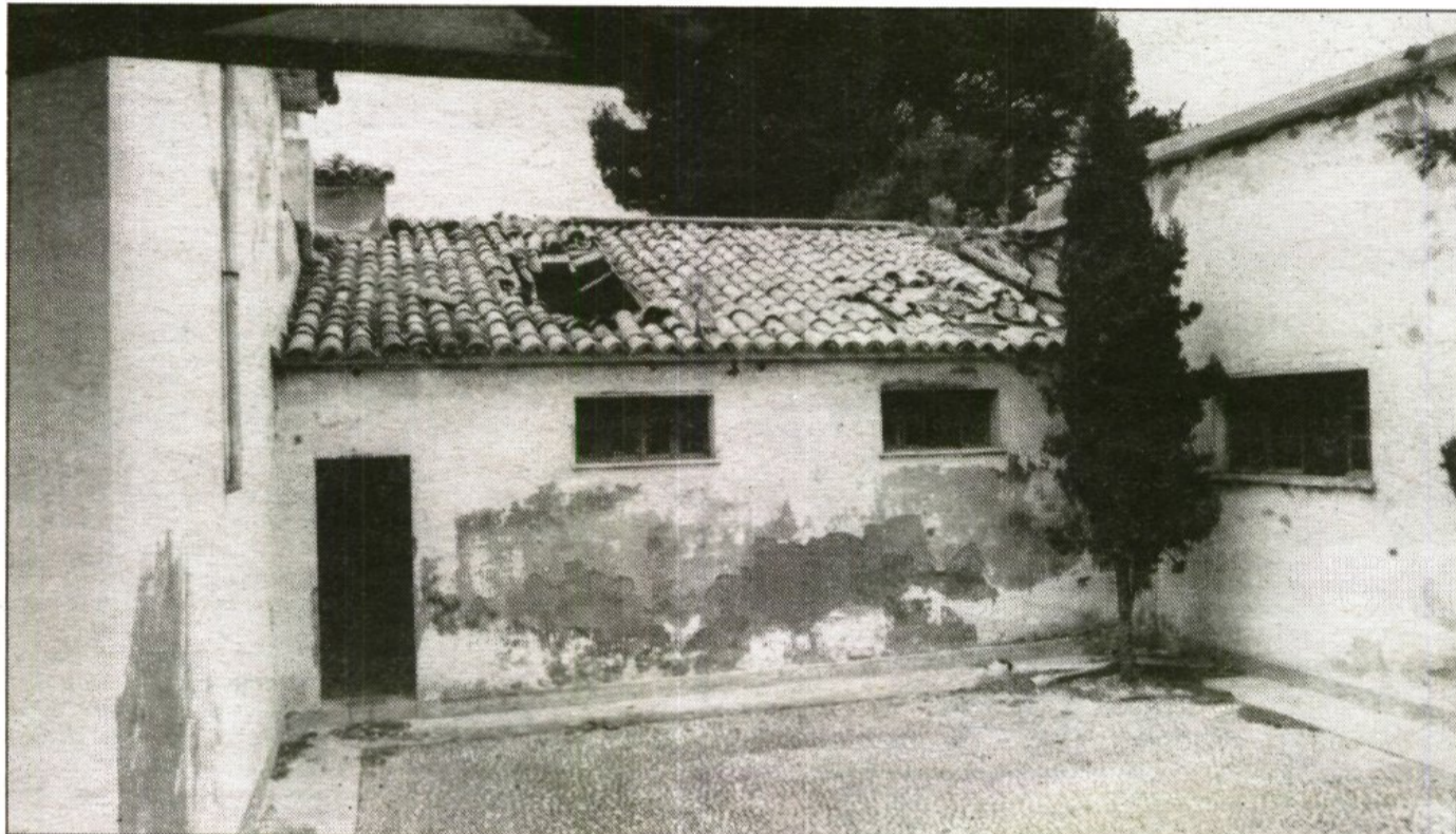
Darrera l'edifici del fons, l'Ajuntament ha construït la paret divisòria amb els terrenys de la Base Naval.
