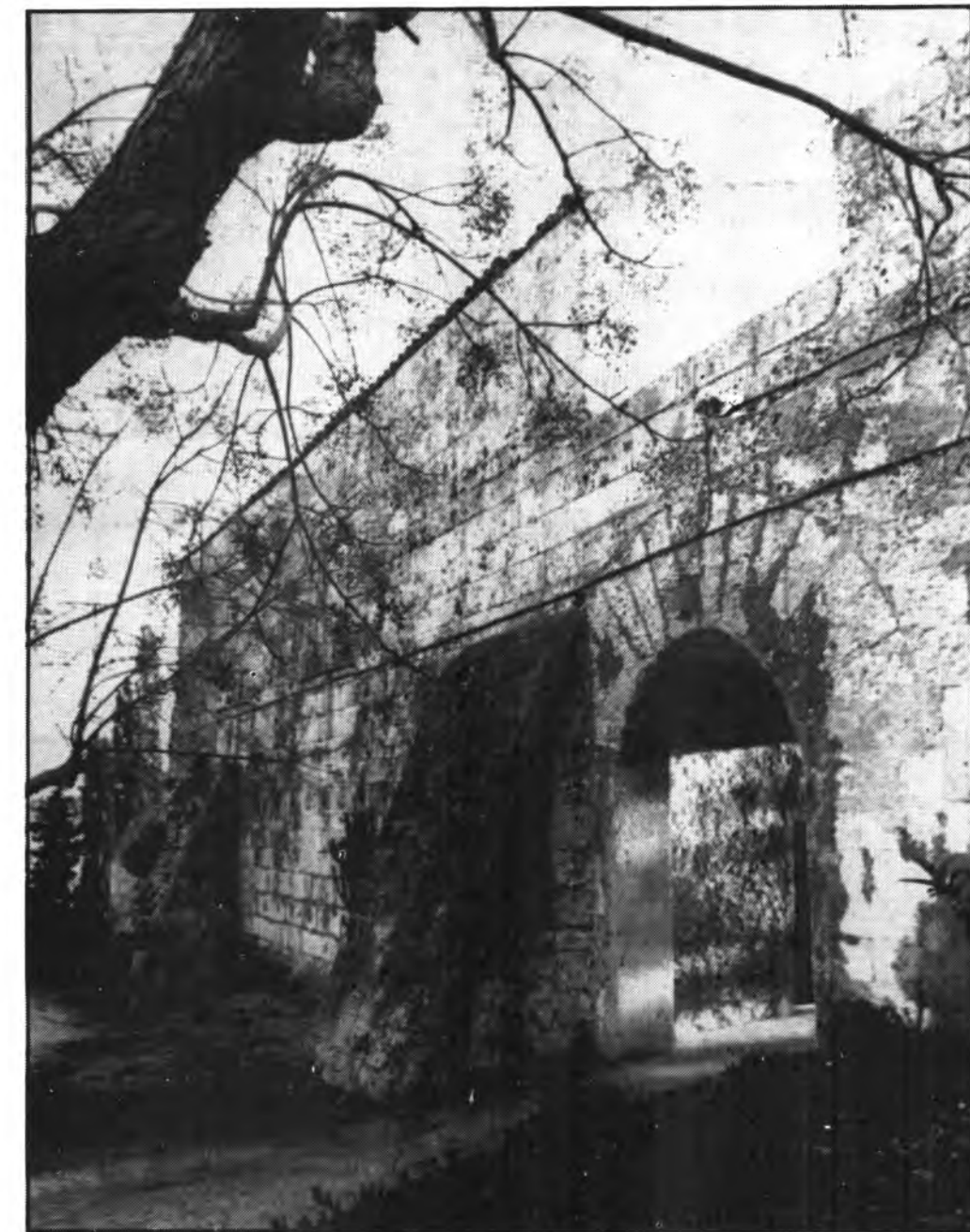
Façana d'un castell de pagès.
