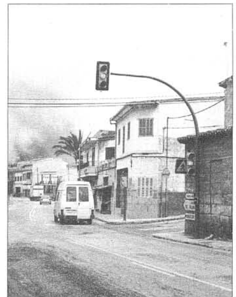
Estat actual de l'asfalt (fot.: Molí Nou)
