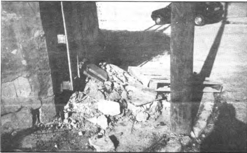
Este aspecto presenta la acera de la calle Torres Quevedo. (FOTO: A. QUETGLAS).
