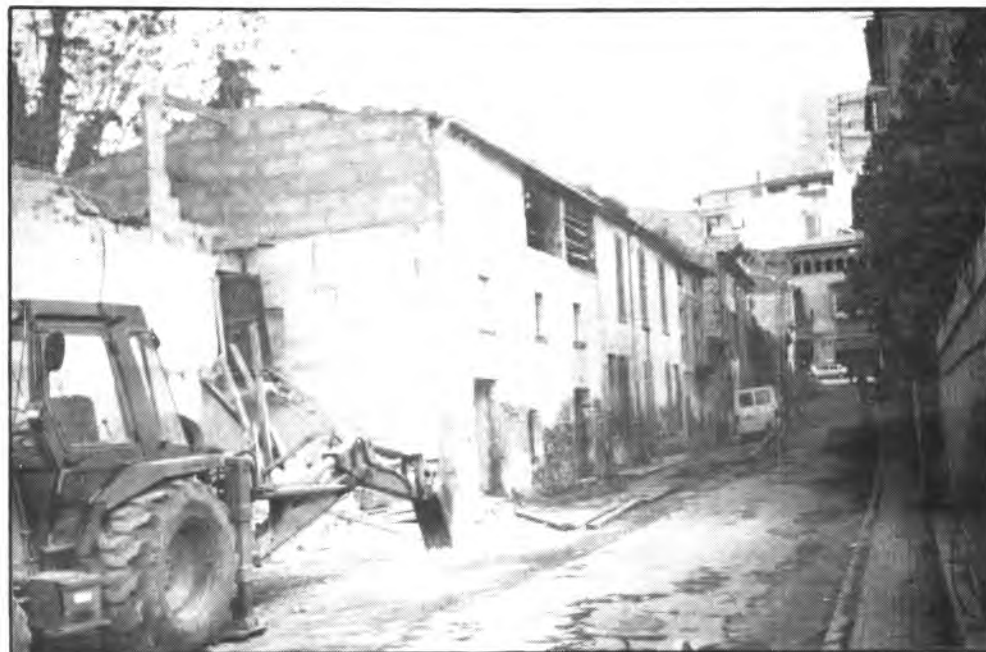
Trabajos de reforma de la Gran Vía Colon - Plaça Quartera. ANDRES QUETGLAS
