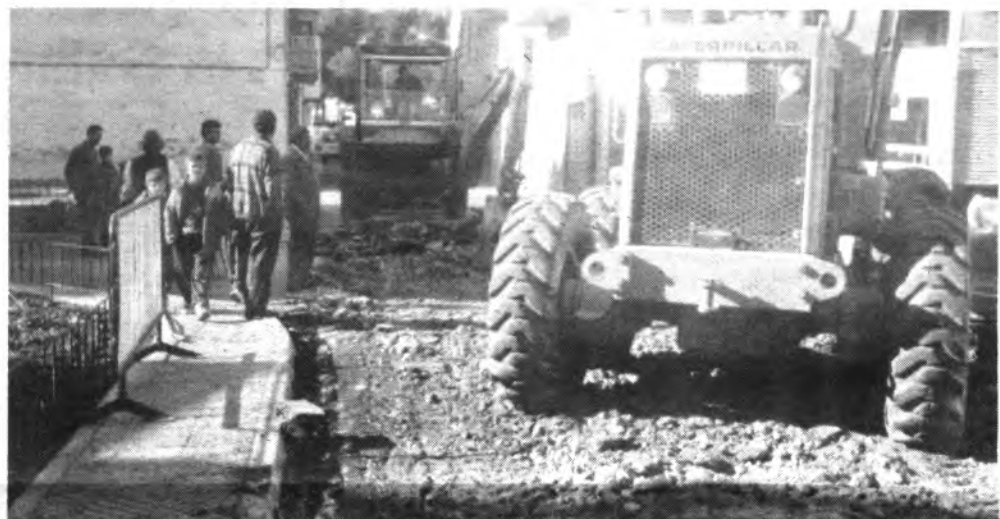
Se iniciaron los trabajos de pavimentación de la calle Biniamar. (FOTO: ANDRÉS QUETGLAS).
