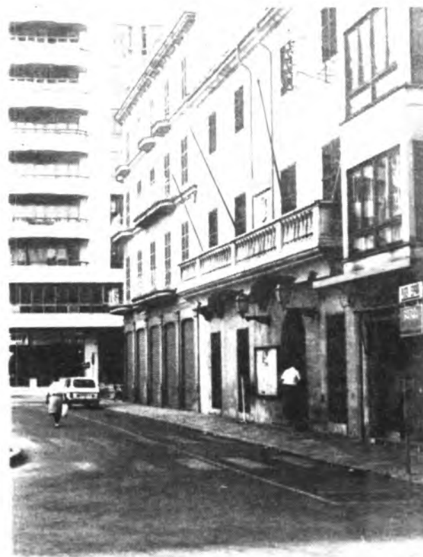
Al fin la casa consistorial estará terminada (Foto: Riera).
