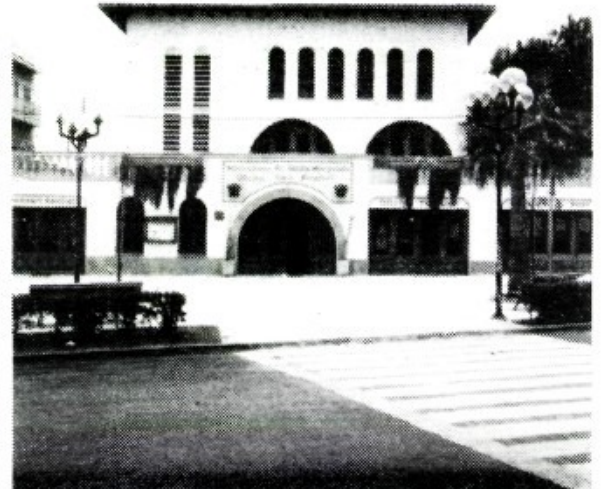
Oficinas Municipales de Can Picafort
