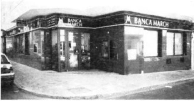
Exterior del nuevo edificio de la Banca March en Cala Millor.
