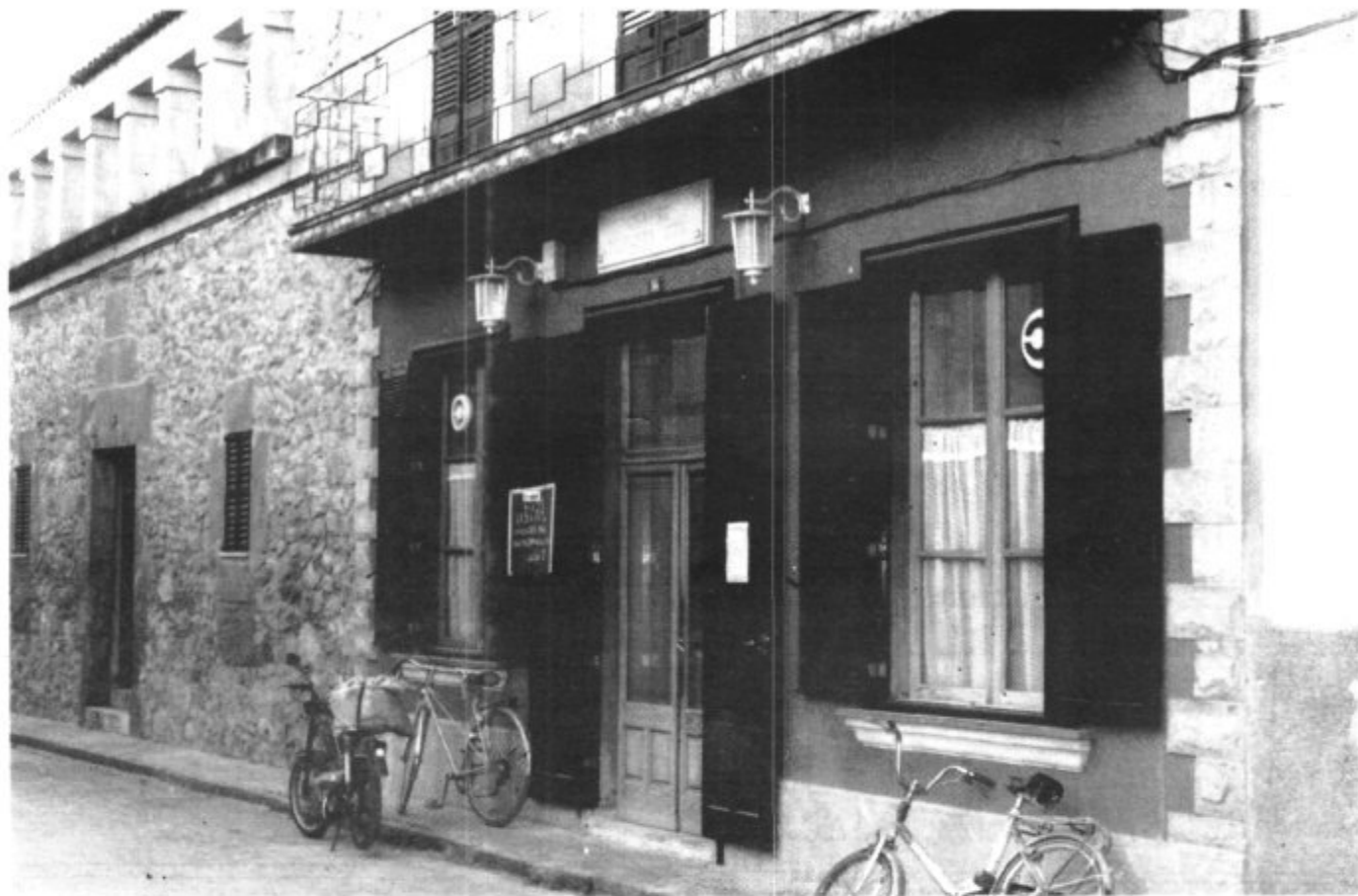
Centro Municipal de la Tercera Edad de Sant Llorenç
