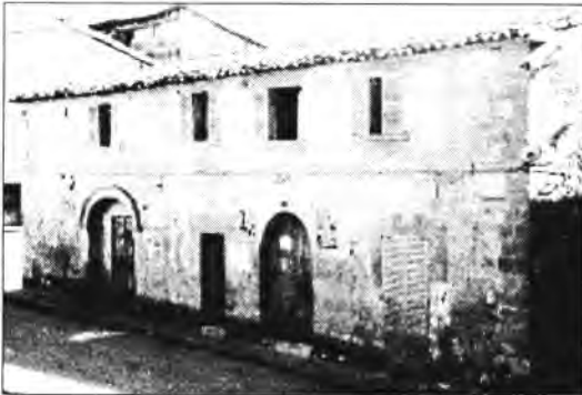
L'antic edifici de l'Ajuntament abans de derruir-lo
