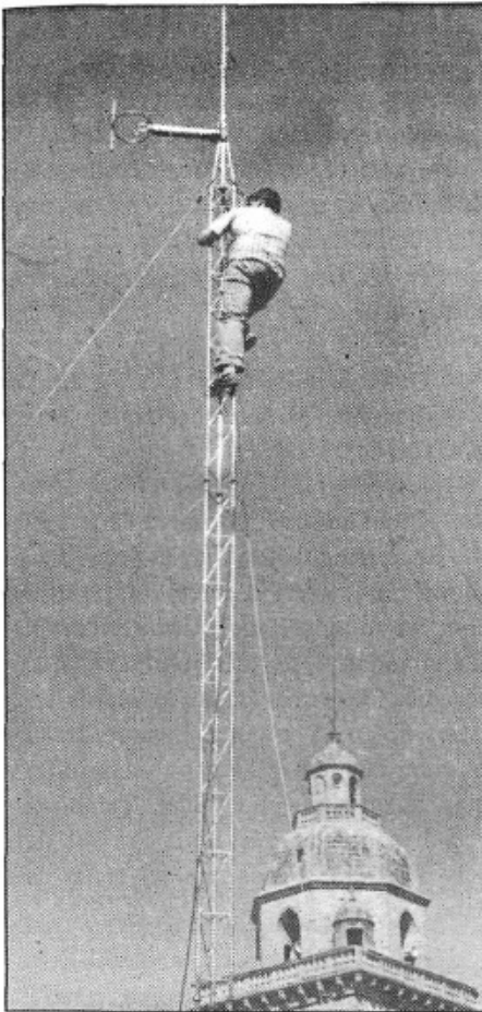
Col·locació de la nova antena de "Ràdio Murta"
