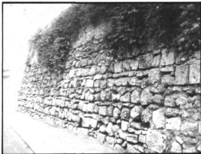
Bastión de San Fernando. Segundo Recinto Amurallado.
