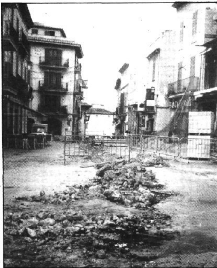
Obras en Plaza Constitución, de Alcudia.
