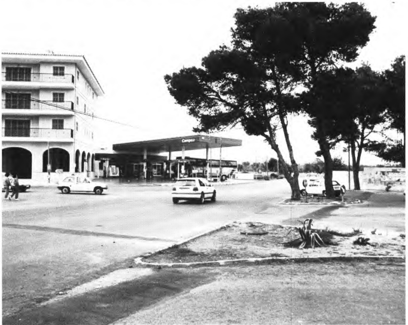
Verger anunció en Manacor la realización de la rotonda de Porto Cristo, el cruce de s'Illot y su carretera hasta Cala Morlanda
