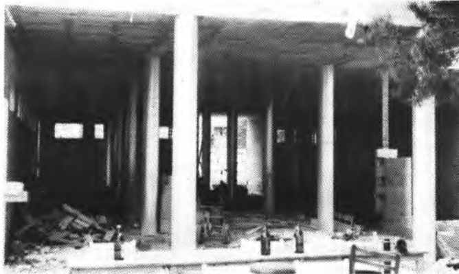
Después de terminar los nuevos vestuarios, así quedará la planta baja de los mismos
