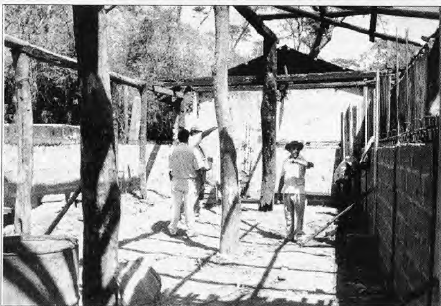
L'escola de Corinto-La Fuente en fase de construcció
