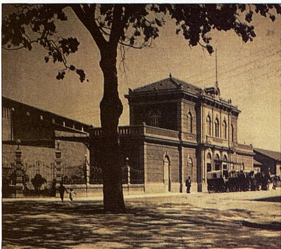
L'enderrocament de les murades de Palma afavorí l'emplaçament definitiu de la nova estació a les proximitats de la dels FFCC de Mallorca
