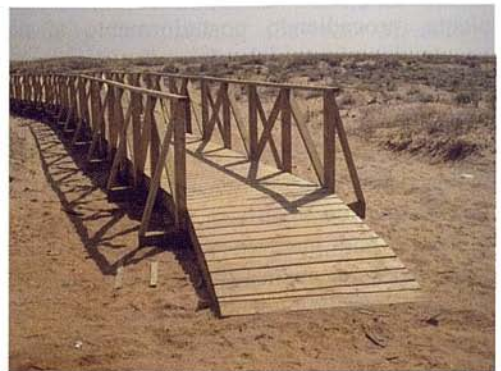
Fig. 8. Pasarela de acceso a la playa.
