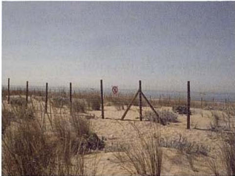
Fig. 7. Cerramiento de protección dunar.
