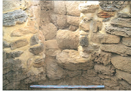
2. Porta descoberta durant la consolidació a T 1.
