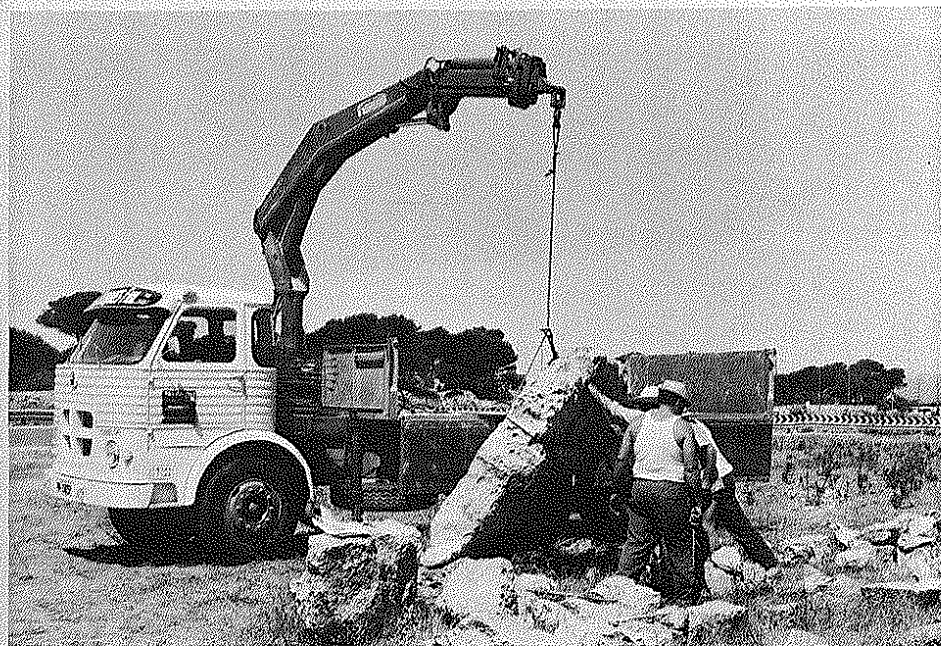
Lámina VIIIId: Reparación del bloque nº 3 del paramento B en su nuevo emplazamiento.
