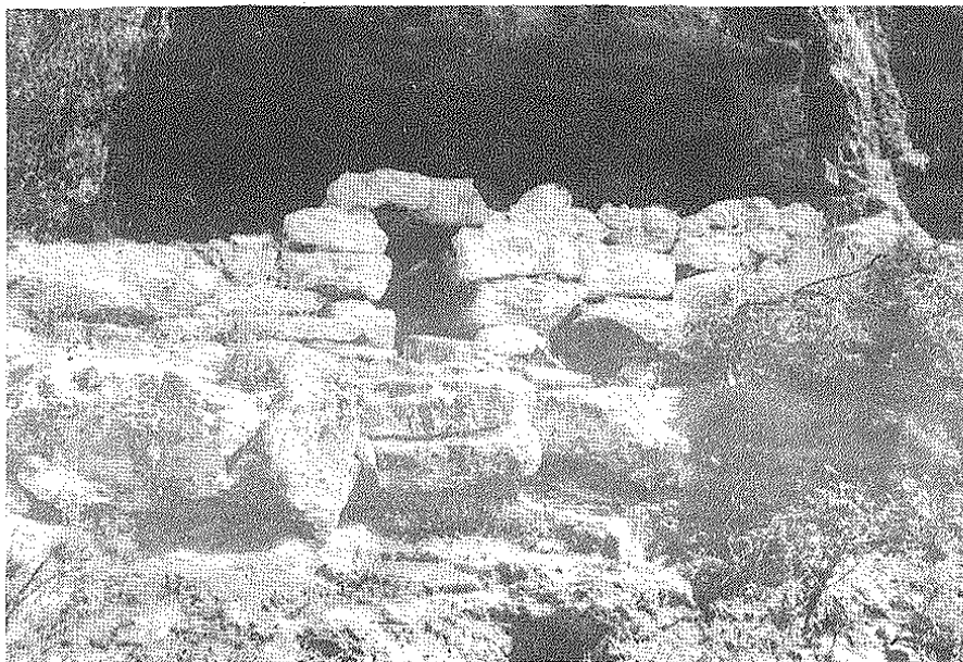
Vista general del cierre ciclopeo
