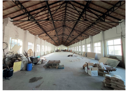
Figura 10. Nau principal del recinte industrial.
