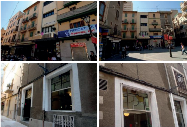
Figura 9. Fotografies de l'exterior del Cafè Cinema Mercantil. Font: Catàleg de patrimoni d'Inca.
