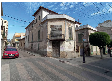
Figura 16. Cantonada de la façana principal.
