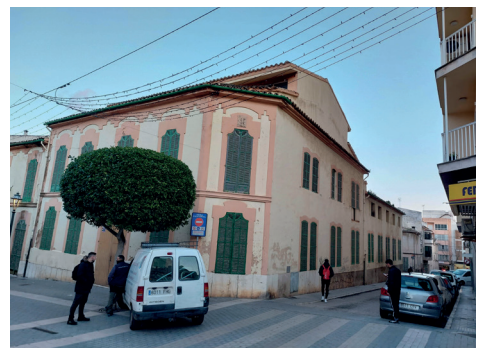
Figura 12. Cantonada de la façana principal.
