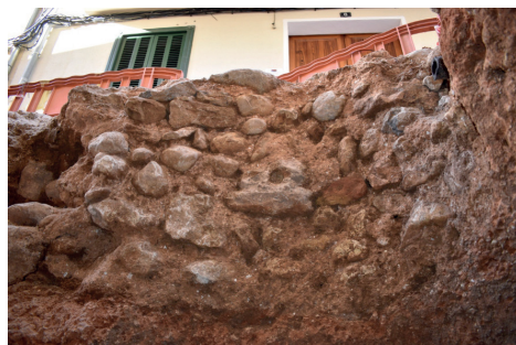
Figura 2. Mur construït amb morter de calç i pedres que conforma la part superior de la paret sud de l'estructura número 2, vista des de l'interior d'aquesta. Font: Raúl Guardiola Navarro i Magdalena Sastre Morro.
