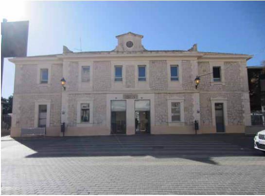
Figura 4. Estació del tren.
