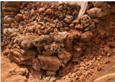
Figura 14. Resultat de la consolidació i la construcció del talús.
