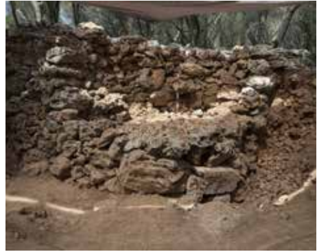
Figura 13. Resultat del procés de reintegració i consolidació del parament extern de la plataforma.
