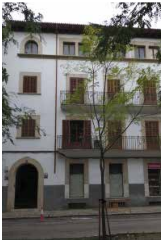
Figura 1. Façana de la Clínica Ferrer, situada a la Gran Via d'Inca.
