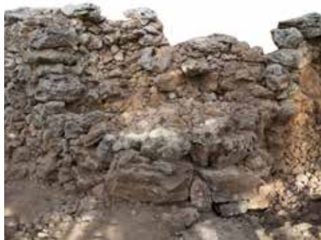
Figura 10. Àrea d'intervenció perfilada prèviament a la consolidació. Figura 11. Procés de reintegració del parament extern de la plataforma.
