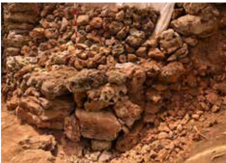
Figura 14. Resultat de la consolidació i la construcció del talús.
