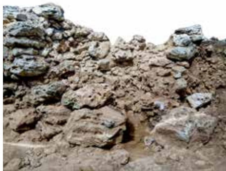
Figura 10. Àrea d'intervenció perfilada prèviament a la consolidació. Figura 11. Procés de reintegració del parament extern de la plataforma.
