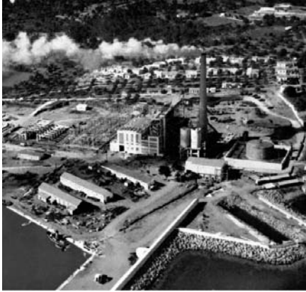
Fig. 1. Central tèrmica del Port d'Alcúdia en funcionament. Vista del 1958. A la fotografia podem veure la primera fase constructiva de la central, ja que encara no s'havia edificat la segona xemeneia.
