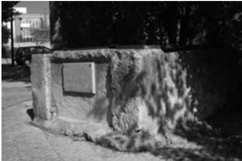
Fig. 17. Arc rodó a Can Monroig
