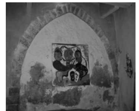
Fig. 16. Arc gòtic paredat a Can Monroig
