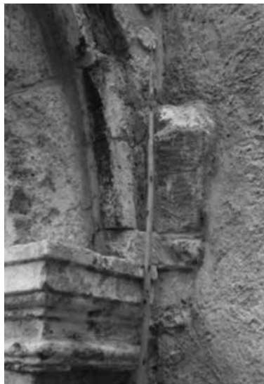
Fig. 18. Arrencada d'un nervi. Pati de Can Monroig
