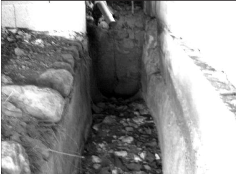
Síquia; a l'esquerra, cantonades de la fibla que permet desviar l'aigua al torrent; al fons, bifurcació de la síquia que es dirigeix als cups
