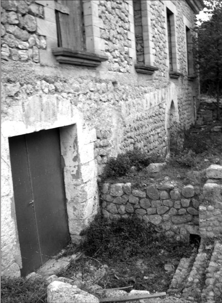
Portal de l'obrador i finestra apuntada sobre els cacaus
