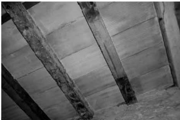
Bigues de coberta procedents del NIXE.
