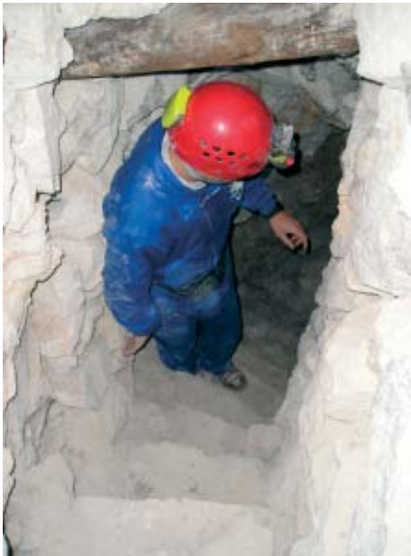
Foto 10. Escaletes de l'Infern, situades quasi al final de la galeria des Forn (mines de guix de les coves del Pilar). Es pot observar una biga de fusta a la part superior i les parets construïdes en pedra seca. Just darrera l'espeleòleg, les escaletes s'aturen per un esbucament. Sembla que es va aprofitar un pou de dissolució dins del guix del Trias per a fer-les (Foto D. Vicens).
