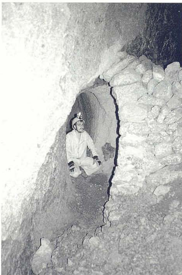
Foto 3: Inicio de galería donde se aprecia la fortificación de la misma mediante mampostería y piedras. Esta galería corresponde a la que aparece en la Fig. 3,13.
