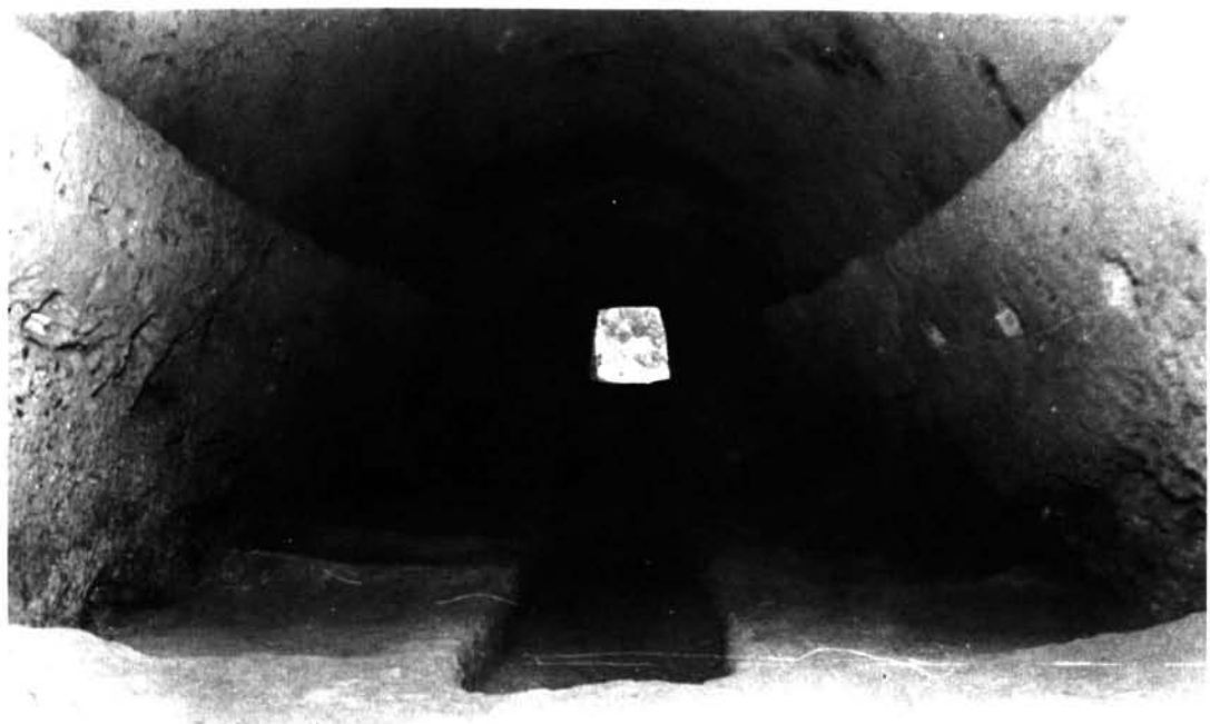
La cámara de la cueva n.º 7 vista desde el ábside de la misma. Se pueden apreciar las repisas laterales, los mechinales abiertos modernamente, la trinchera central y los característicos resaltes de las gradas.
