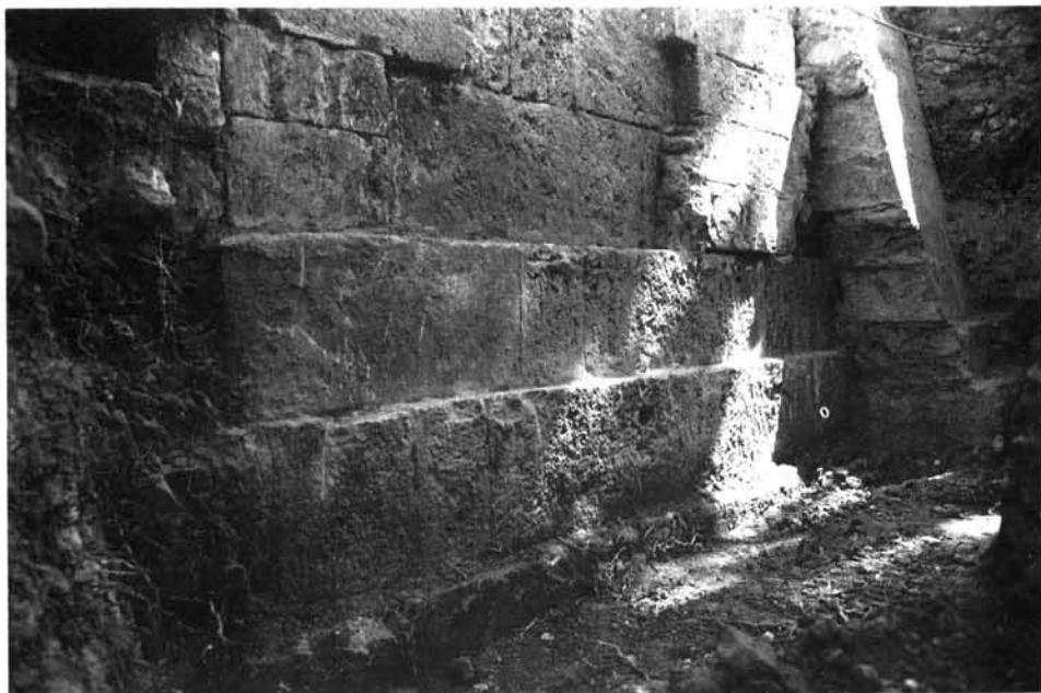
Fonaments de la Torre de Xaloc, grans blocs disposats de cap i traves.
