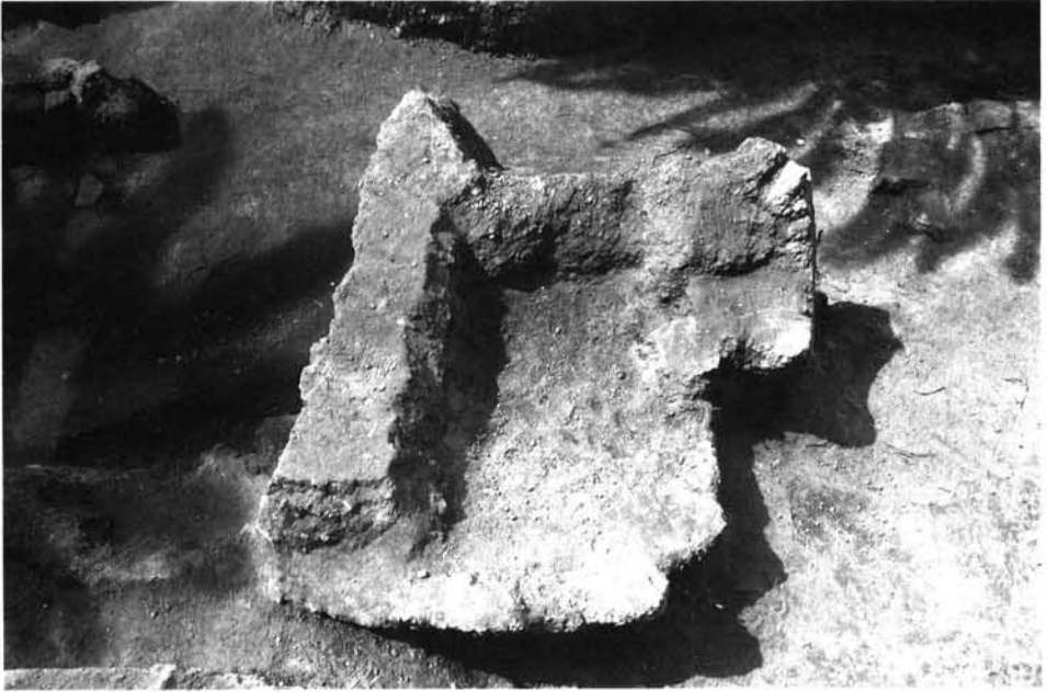
Part superior de la torre de Migjorn, fabricada en tècnica de tapia, esbucada a causa de les remodelacions realitzades després de la conquesta.
