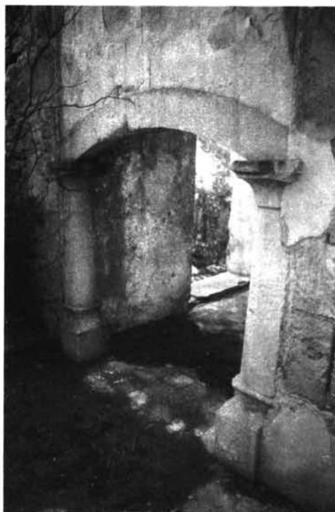
Fig. 9.- Pórtico de una de las viviendas.
