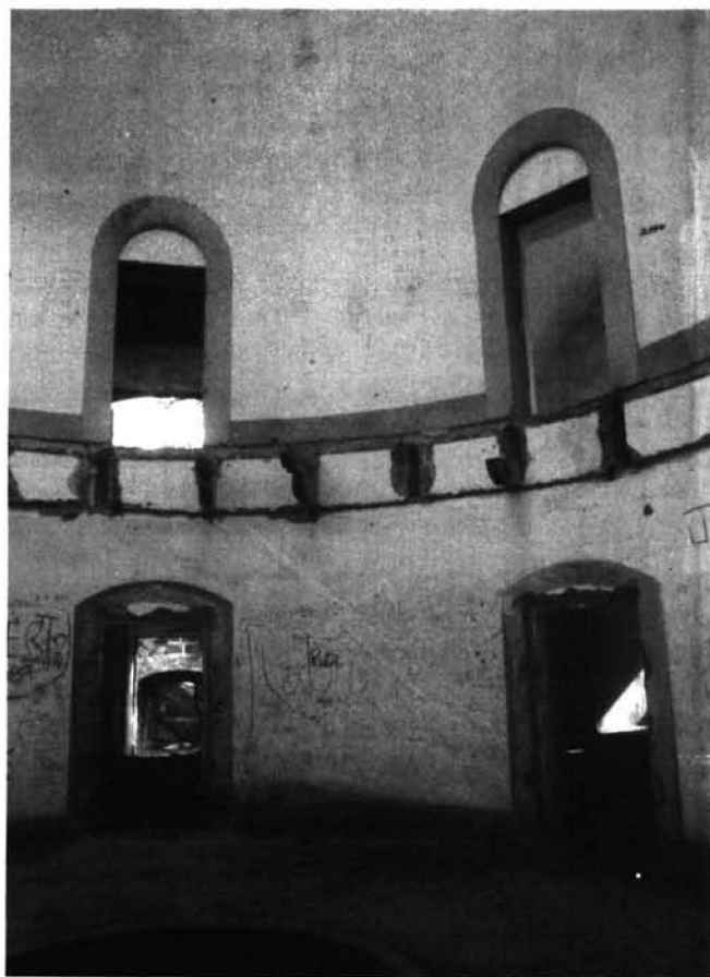
Fig. 4 y 5.- Vista parcial del camino de ronda e interior del patio central circular.
