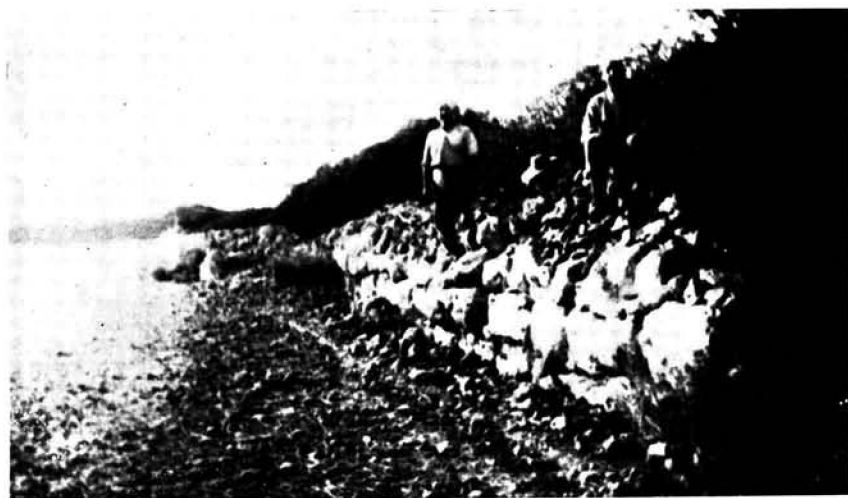
Muralla del poblado de Sa Talaia (Son Catlar Nou) hoy completamente demolida. Fotografía tomada por D. Juan Vidal Ollers en el año 1932.
