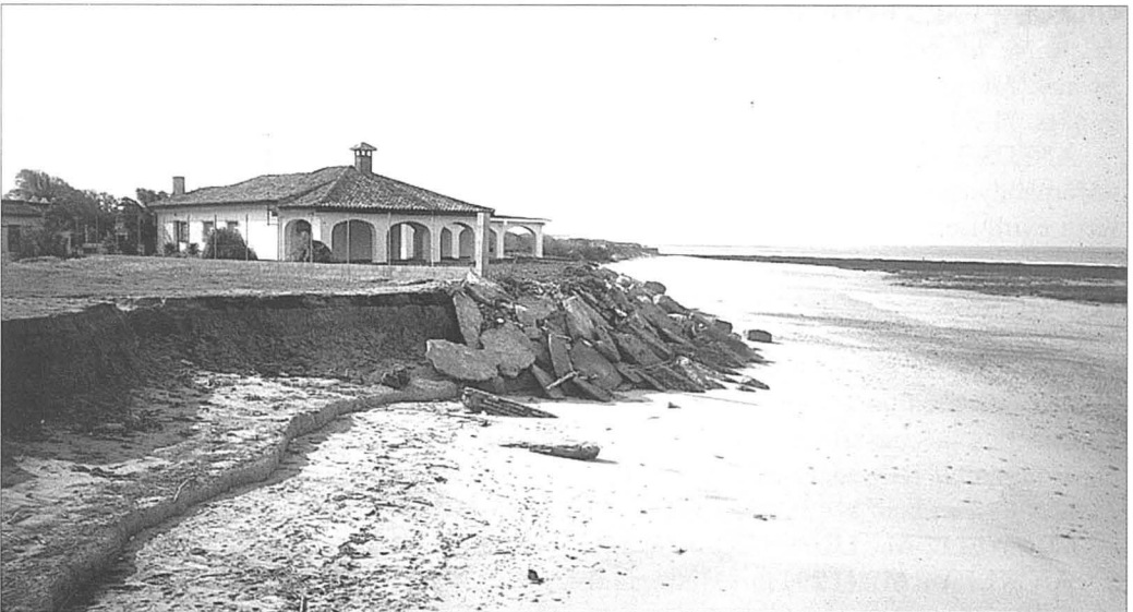
Figura 7. Revestimiento de escollera instalado para proteger una vivienda de verano en la playa de Peginas. Obsérvese a la izquierda la erosión del microacantilado cercano.
