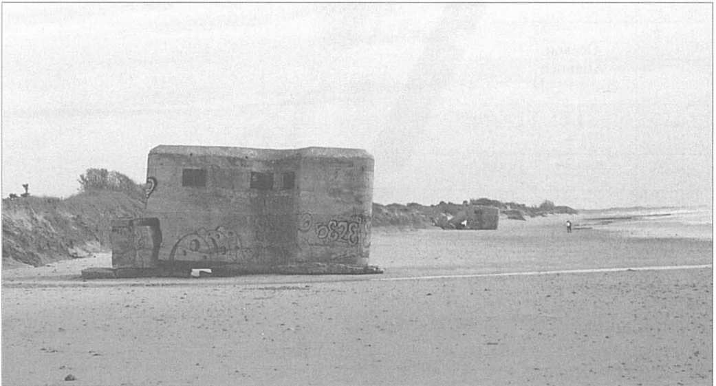
Figura 6. Búnker caído en la zona intermareal de la playa de La Ballena. Originalmente esta estructura fue construida en los años 30 encima del acantilado en retroceso.
