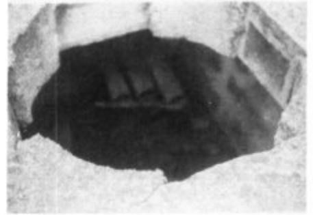
Sa Canova urbanizada. Troneras concluidas con conducciones para electricidad y teléfono.
