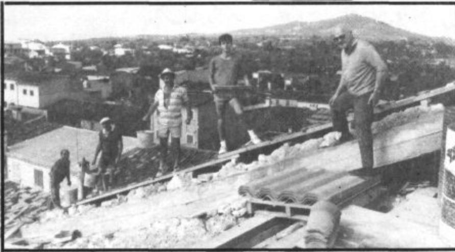
LAS LAMINAS DE URALITA IMPEDIRAN QUE SE PRODUZCAN NUEVAS GOTERAS
