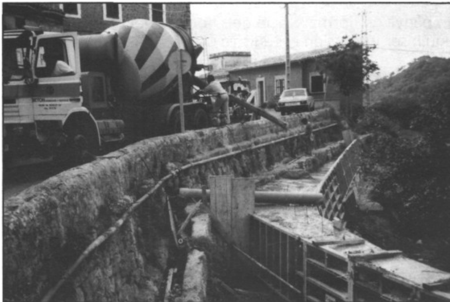
Obres d'ampliació del pont
