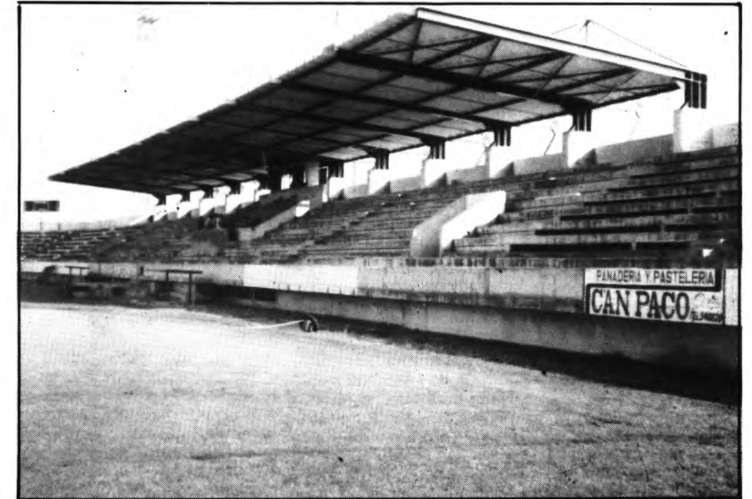
La falta de instalaciones, uno de los problemas
